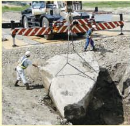
●「弘法の枕石」引き揚げ作業
