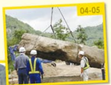
「弘法の枕石」引き揚げ作業
