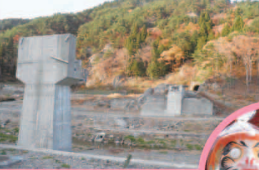
▲津波で流された線路
