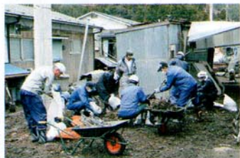
屋外の泥撤去作業
